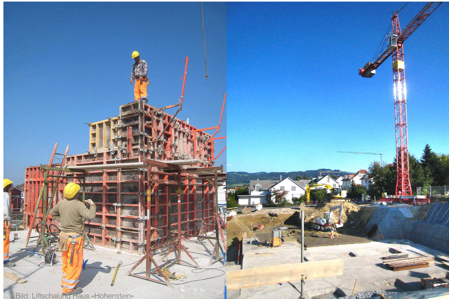
Bild: Liftschalung Haus «Hohenstein»
